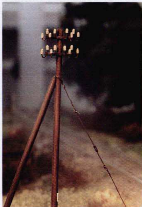
Słup telegraficzny z odciążeniem.
