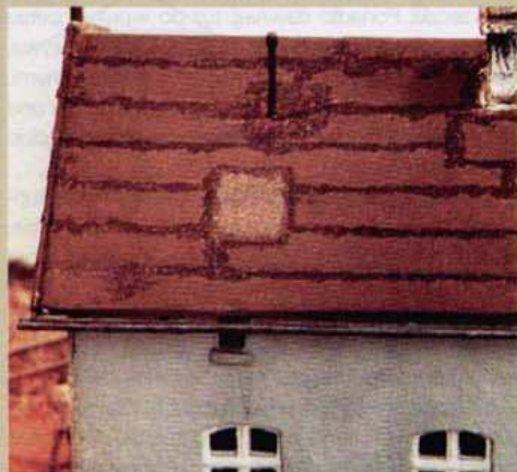
Fot. 1. Imitacja papy na dachu - paski papieru pomalowane na czarno farbą plakatową. Na połączeniach - smoła wykonana z barwionego na czarno wickolu. Widoczna łata z nowej papy - naklejony kawałek papieru ściernego o granulacji 800.
