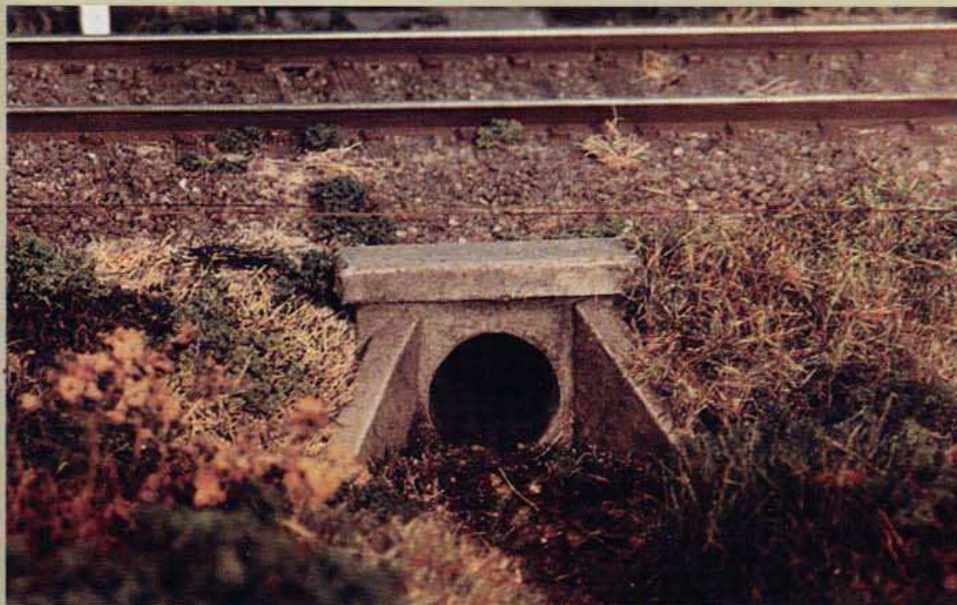
Fot. 6. Głowica (wylot) przepustu rurowego. Całość wykonana z kartonu. Fakturę betonu otrzymano stosując metodę wklepywania farby emulsyjnej.
