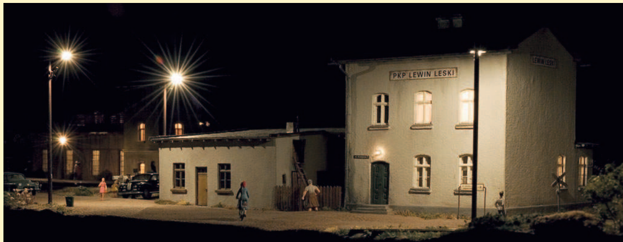
Na peronie stacji Lewin Leski.
