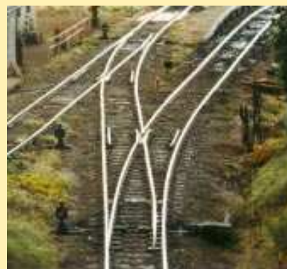
Fot. 4. To samo połączenie widoczne z niższego poziomu. Rozjazdy wydają się być krótsze i mieć większy skos.
