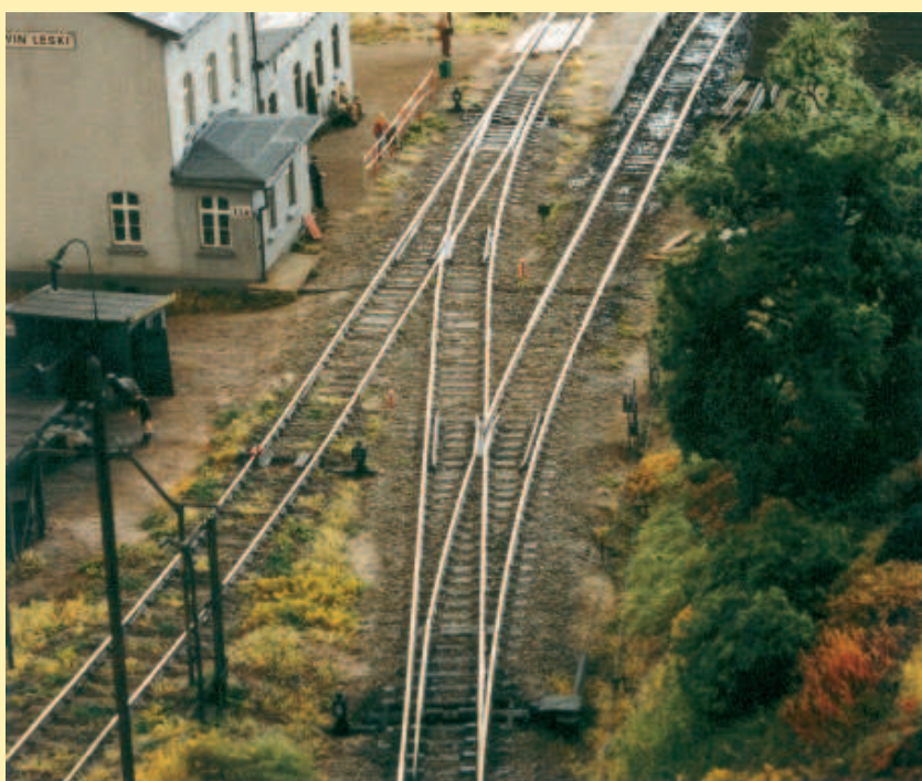
Fot. 3. Gotowe połączenie torów dwoma rozjazdami zwyczajnymi o kącie zwrotu 10°.
