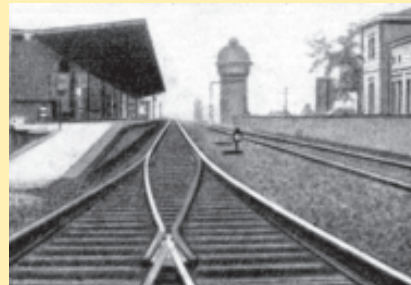
Fot. 2. Rozjazd łukowy dwustronny w oryginale.
