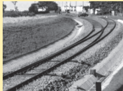
Fot. 1. Rozjazd łukowy jednostronny w oryginale.
